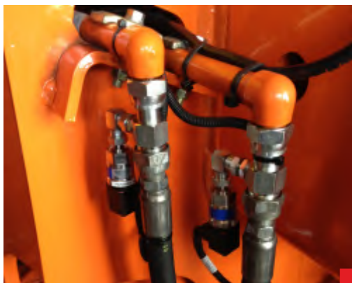
napojení snímače hydraulického tlaku
