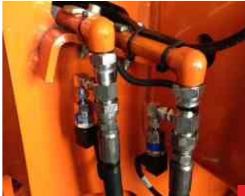
napojení snímače hydraulického tlaku
